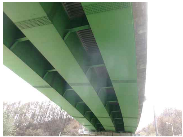
바닥판 하면 및 거더 전경
