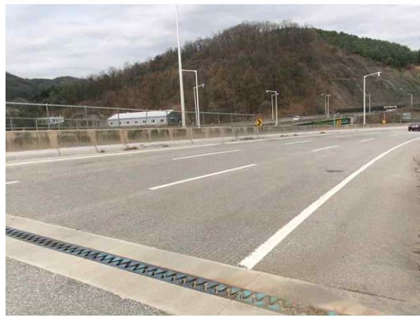
교량 상부 전경
